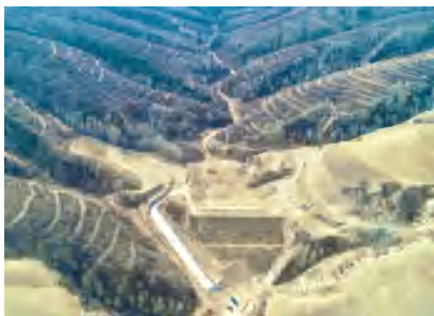
岢岚县小南沟淤地坝除险加固工程
