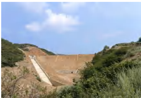
汾西县羊马坪大型淤地坝
