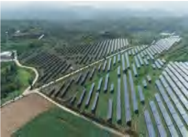
运城市垣曲县华昌新能源 5万千瓦光伏发电项目
