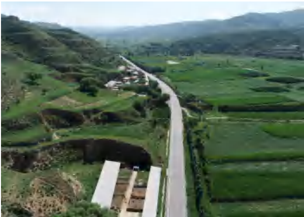
山西省集中连片特困地区省道岢 大线阳嵩塔至松井段公路改建工程
