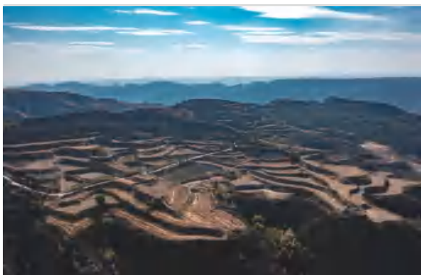
晋中市灵石县坡耕地水土流失综合治理工程
